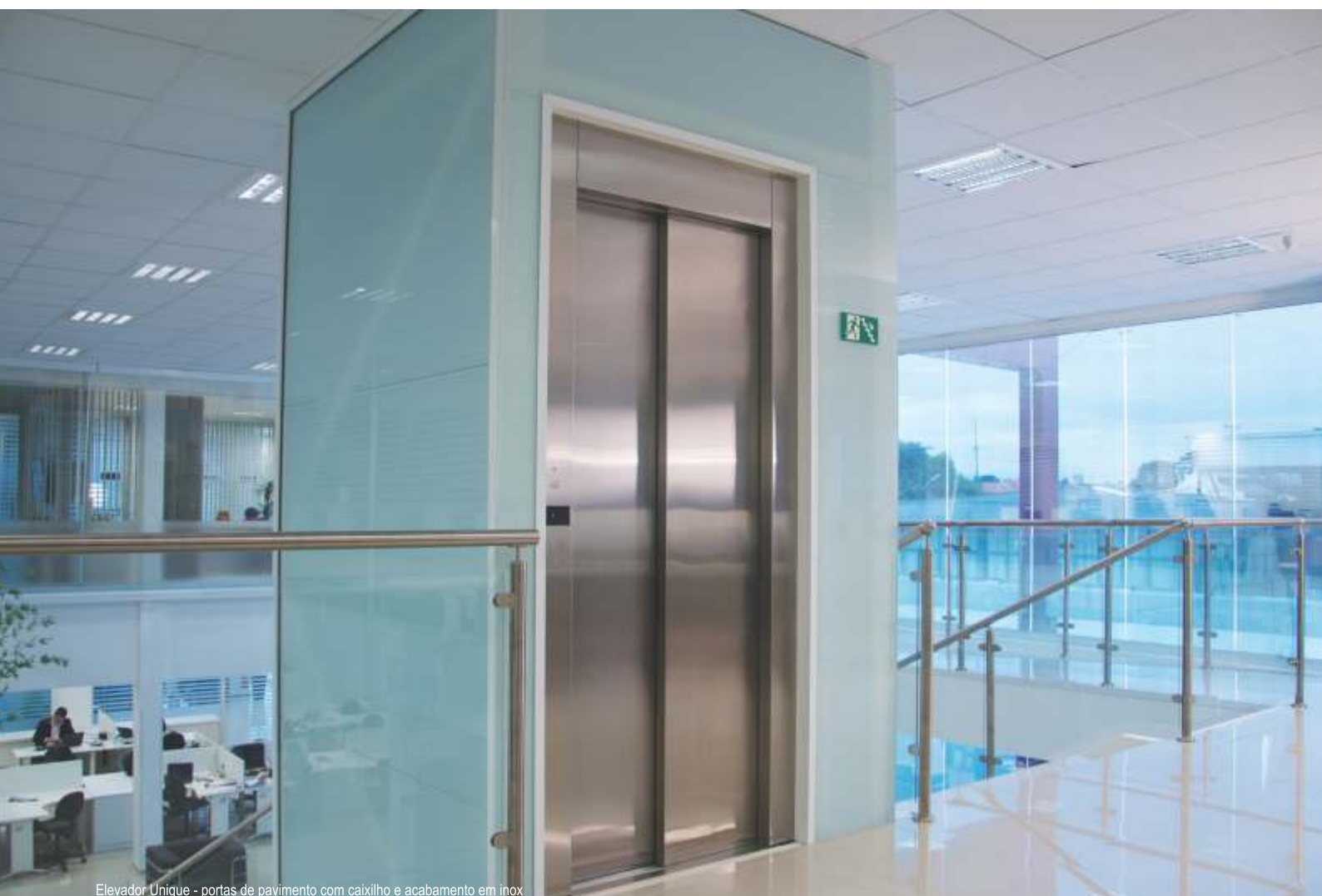
Elevador Unique - portas de pavimento com caixilho e acabamento em inox
